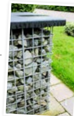
Gabioner kan fyllas med t ex sten av granit, kalksten eller sandsten.
